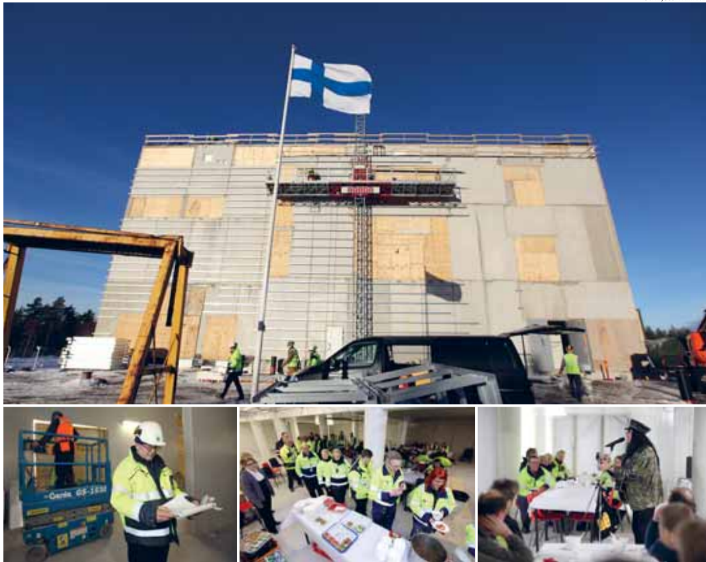
ONKALOn ilmanvaihtorakennuksen harjakaisissa tutustuttiin itse rakennukseen sekä nautittiin harjakaislounaasta ja rok-tähti Juissi Läskisen ohjelmasta. Kesällä 2011 valmistuvan rakennuksen päätehtävänä on huolehtia maanalaisen tutkimustilan ilmanvaihdosta.
