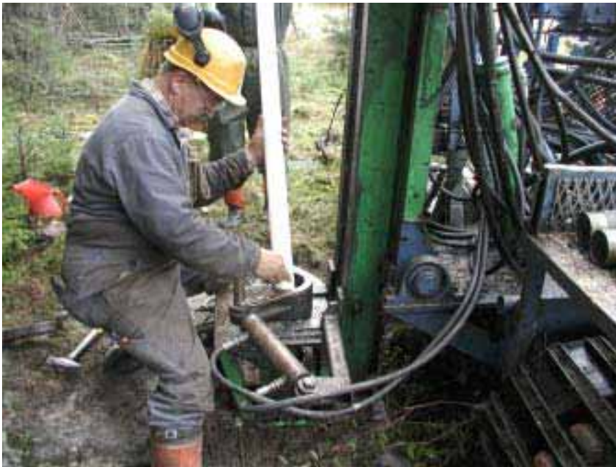
Olkiluotoon asennettiin syksyllä 2001 kahdeksaan paikkaan yhteensä 16 siiviläputkea maapeitteeseen liittyvien hydrologisten ja kemiallisten ilmiöiden tutkimiseksi.
