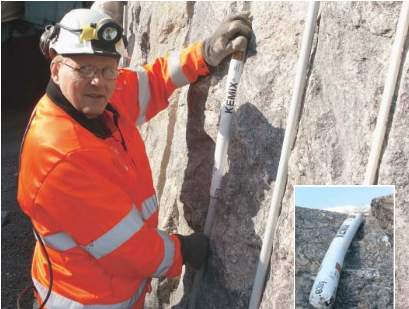
Martti Kähkönen Kalliorakennus Oy:stä sanoo, että Olkiluodossa räjäytykset tehdään mahdollisimman pienellä räjähdysainemäärällä. Tunnelia ympäröivä kallio halutaan säilyttää mahdollisimman ehjänä.
