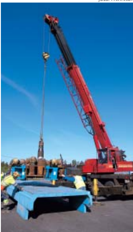
Posiva käyttää Olkiluodossa ruotsalaista urakoitsijaa nousunporauksessa. Avarrusterän halkaisija on 3,5 metriä. Kesäkuun alussa ONKALOon porattu poistoilmakuilu toimii raitisilmakanavana.
