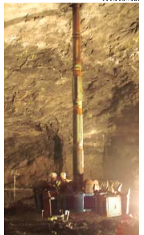
Posiva käyttää Olkiluodossa ruotsalaista urakoitsijaa nousunporauksessa. Avarrusterän halkaisija on 3,5 metriä. Kesäkuun alussa ONKALOon porattu poistoilmakuilu toimii raitisilmakanavana.
