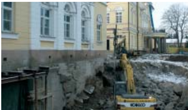
Uusi yhdistyksiä kaivetaan itäisen sivurakennuksen ja päärakennuksen välille.
