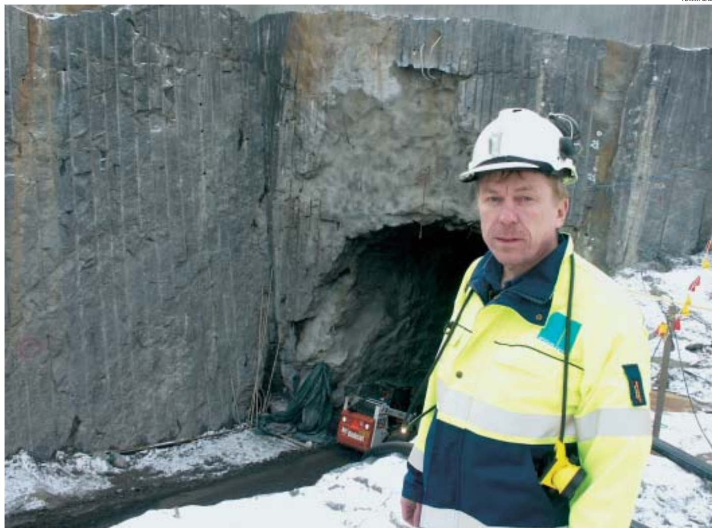
Noin 130 metriin edennyttä ONKALON tunnelia on injektioitu eli tiivistetty tarkasti. ”ONKALOSSA käytetään ainoastaan ultrahienoa sementtiä, jotta vieraita aineita joutuisi kallioon mahdollisimman vähän”, Pauli Syrjänen Gridpoint Finland Oy:stä kertoo.
