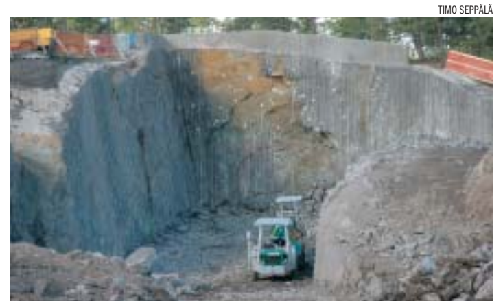
ONKALOn avoleikkauksen louhinta saatiin päätökseen syyskuun alkupuolella.
