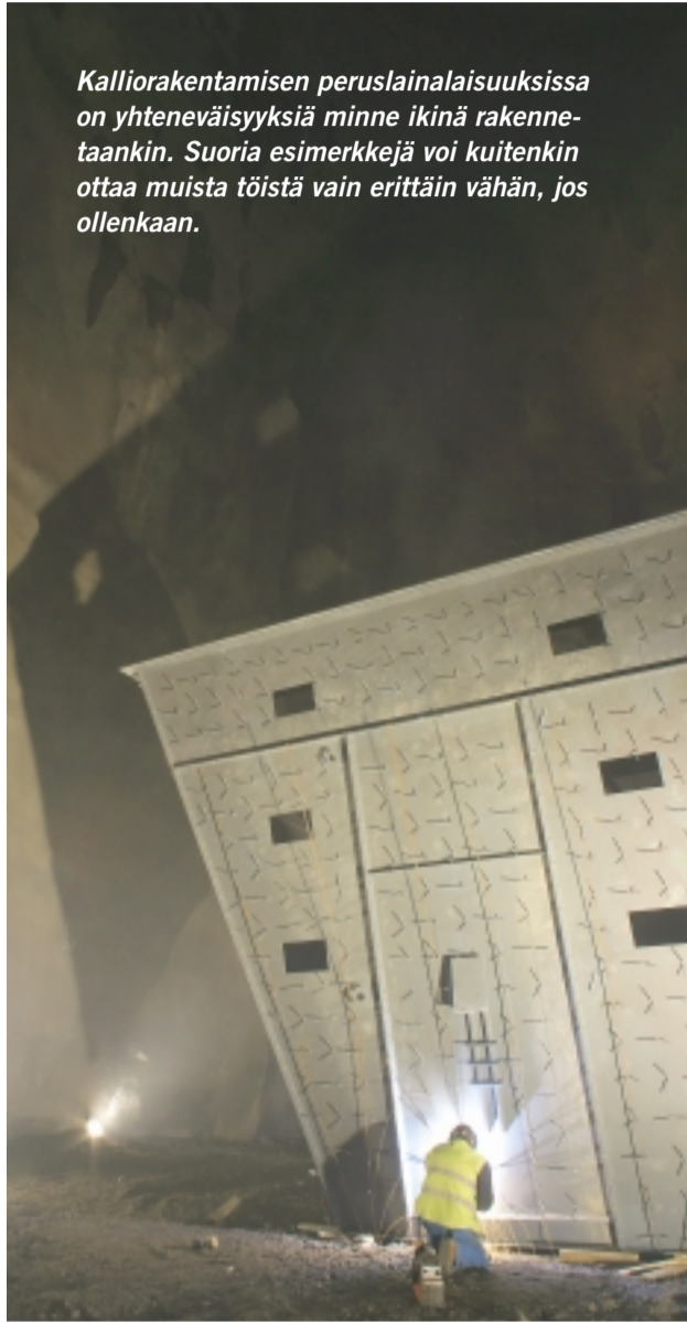
Pudotuskululun teräsnielu hitsattiin kuntoon siilon pohjalla. Kaiken on suunniteltu olevan Salmisaarella valmistettu ensi kesänä.
