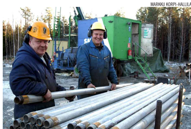
MARKKU KORPI-HALLILA Vuoden viimeisen kairanreiän eli KR 23:n maastotyöt aloitettiin lokakuun puolivälissä.
