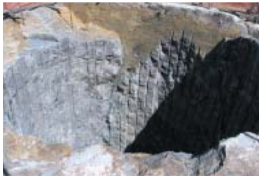
Tuloilma- ja hissikuluyhteys on louhittu valmiiksi 11 metrin syvyyteen. Kuilun halkaisija on kuusi metriä, ja se on louhittu alhaalta ylöspäin räjäyttämällä. Kuilun panostus tapahtui maanpinnalta käsin.
